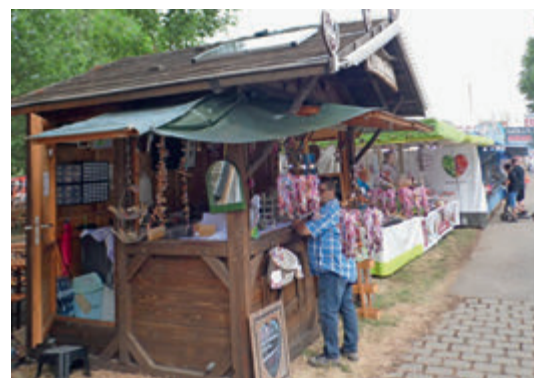
PV hält Einzug im Marktbereich - kostensparend ohne Netzanschluss wird die LED-Beleuchtung der „Herzl Stubn“ von Conny Kauffmann über eine Batterie gespeist, die tagsüber von zwei auf den Dachseiten angebrachten Photovoltaik-Platten geladen wird.
